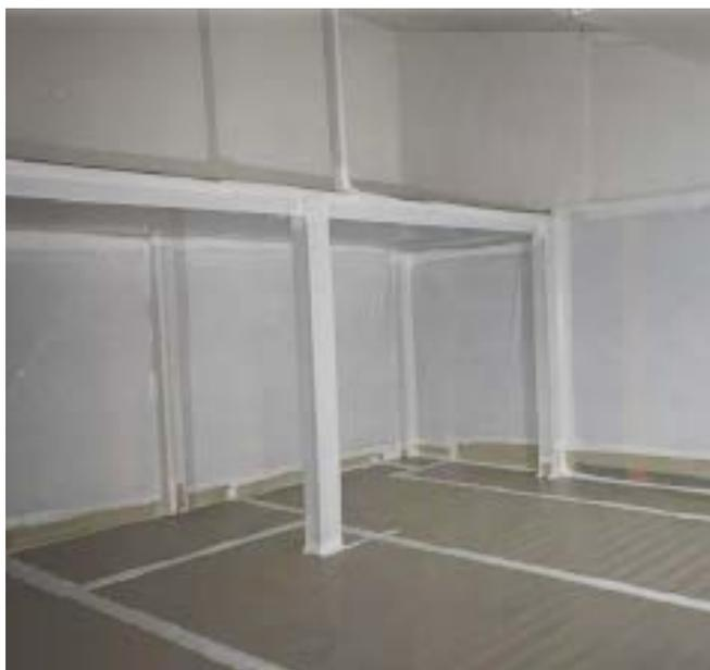
Vue de mise en œuvre de protection de surfaces non décontaminables
