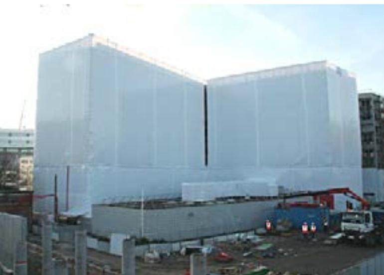
Exemple de mise en œuvre d'un thermo rétractable sur un bâtiment complet
